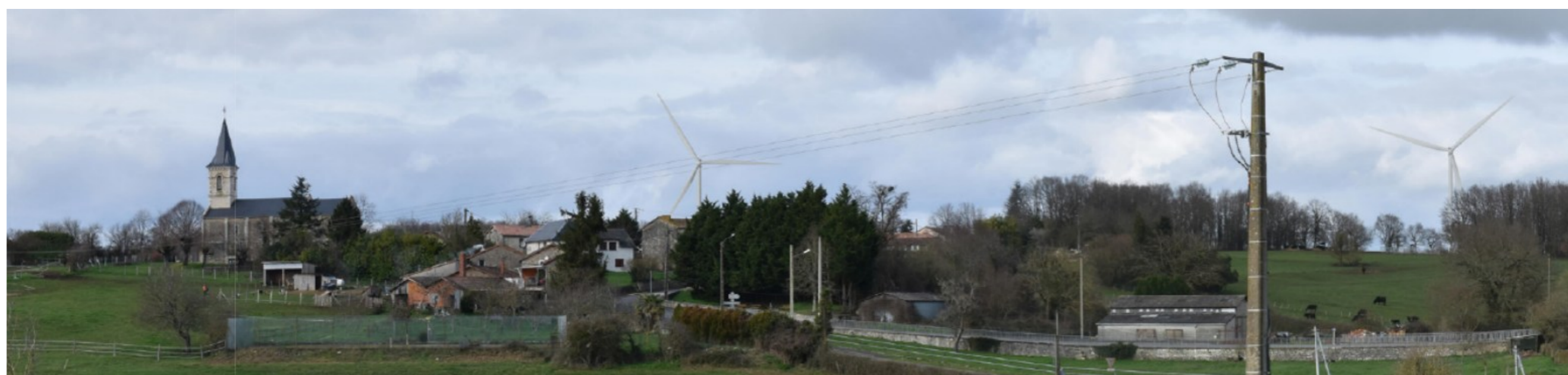
Photographie 4 : Photomontage (PM15) depuis la D35a en entrée sud de Surin (église de Surin à l'extrême gauche) - impact modéré (Source : ENCIS Environnement)
