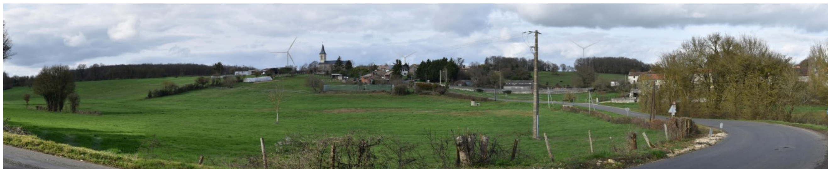
Photographie 19 : Analyse comparative des variantes - Photomontages depuis la D35 au sud du bourg de Surin – Variante 2 (Source : ENCIS Environnement)
