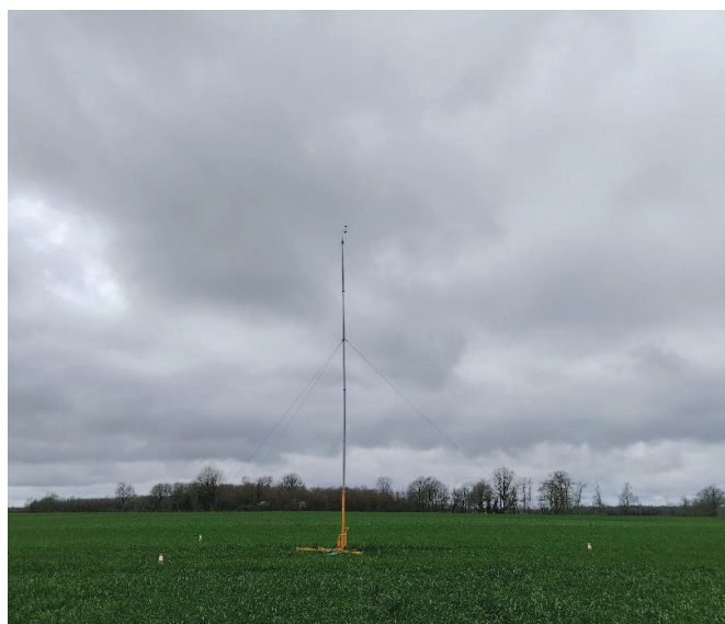
Figure 5 : Photographie du mât installé sur site
